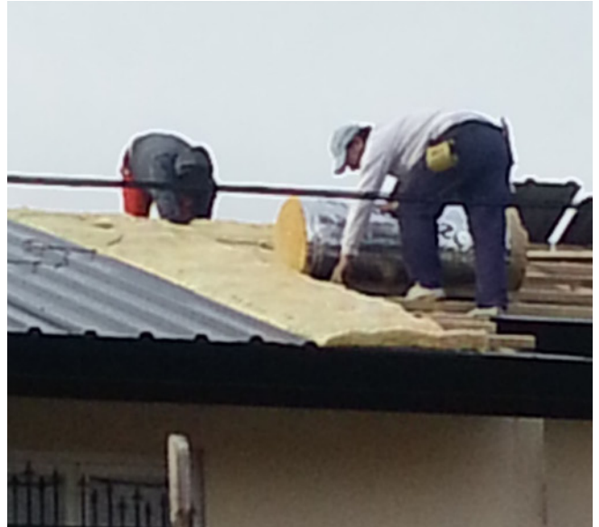
Las chapas se colocan a medida que se avanza con la colocación de la lana para evitar que quede expuesta.
