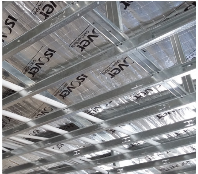
Cielorraso suspendido debajo de cubierta de chapa de pequeñas luces aislada con Rolac Plata Cubierta.
