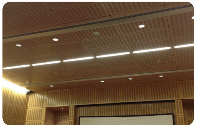
Centro Cultural CCK, revestimiento en paredes y cielorrasos.
