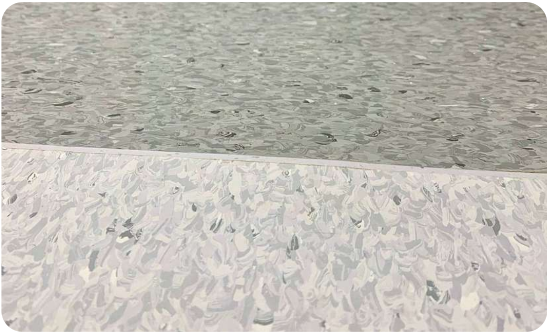
Cordón de soldadura
