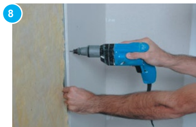
8 Atornillado de las placas Instalar las placas horizontales, elevadas del piso como mínimo 10 mm. Fijar las placas a la estructura por medio de tornillos autoperforantes punta aguja, distanciados 250 mm entre sí y a 10 mm del borde de la placa.
