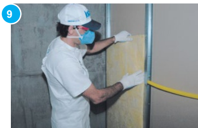
9 Colocación de aislación
