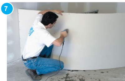
7 Curvado de las placas de yeso (en seco) Situarse la placa transversalmente a la estructura, presionar contra ella y fijarla con tornillos autoperforantes, desde un extremo hacia el otro (radios mayores).
